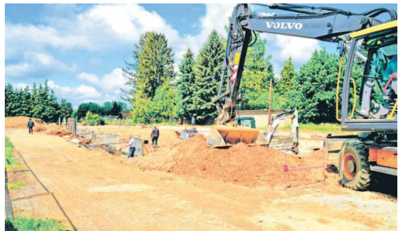
Hier stand das ehemalige Vereinsheim. Im Frühjahr 2021 soll das neue Gebäude voraussichtlich bezogen werden.
